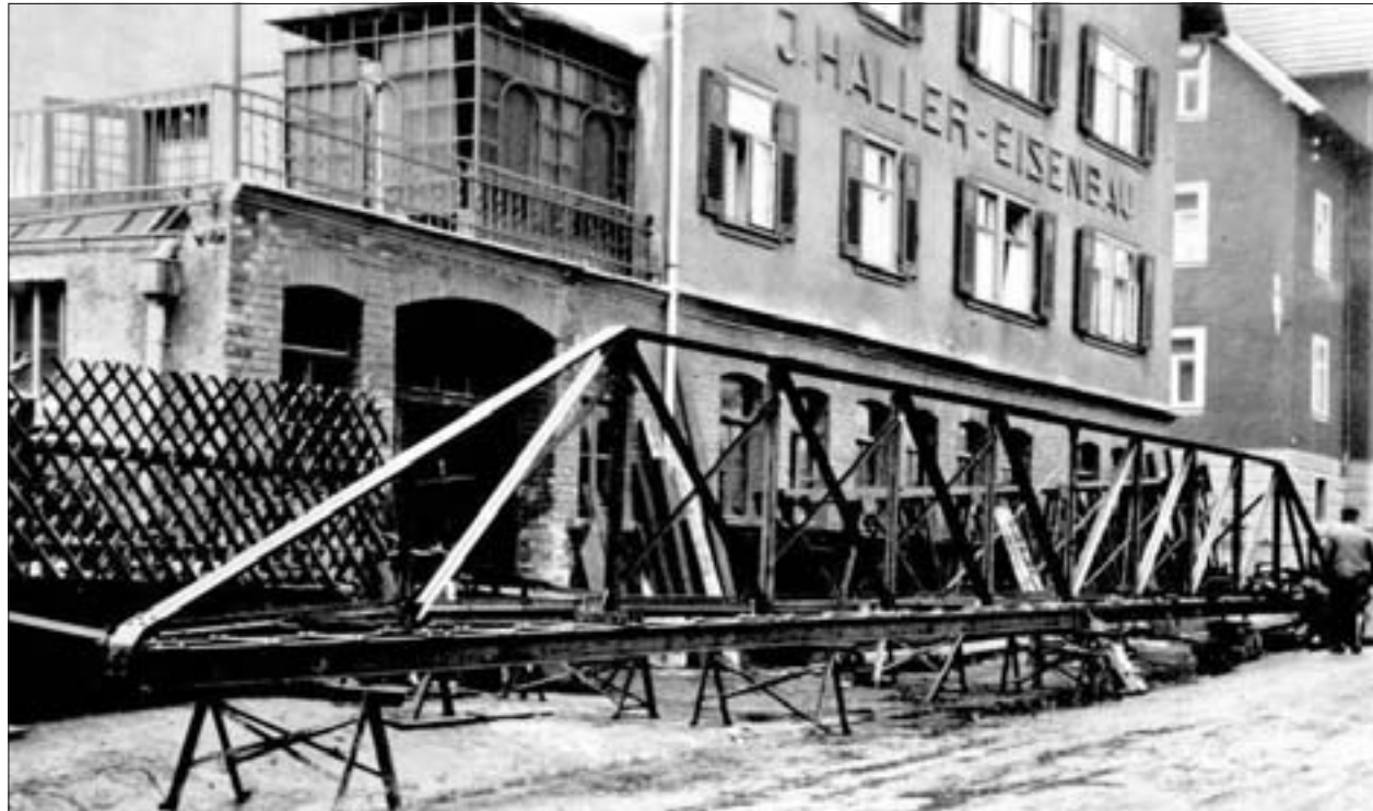
Jakob Haller begann am Stammsitz der Familie in der Muslen als erster in der Ahnenreihe industriell Metallbauwerke zu produzieren. Wenn der Platz in der Werkstatt nicht ausreichte, wurde das Objekt einfach auf der Straße fertig montiert.
