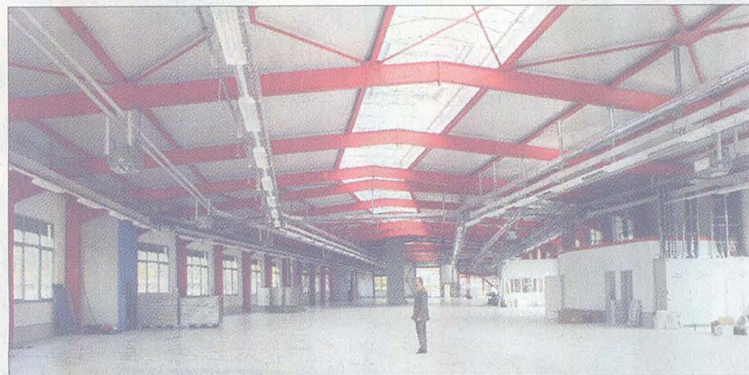
In der Firmenfarbe und mit „Knick“ (wegen des Donauverlaufs) zeigt sich die neue Halle.
