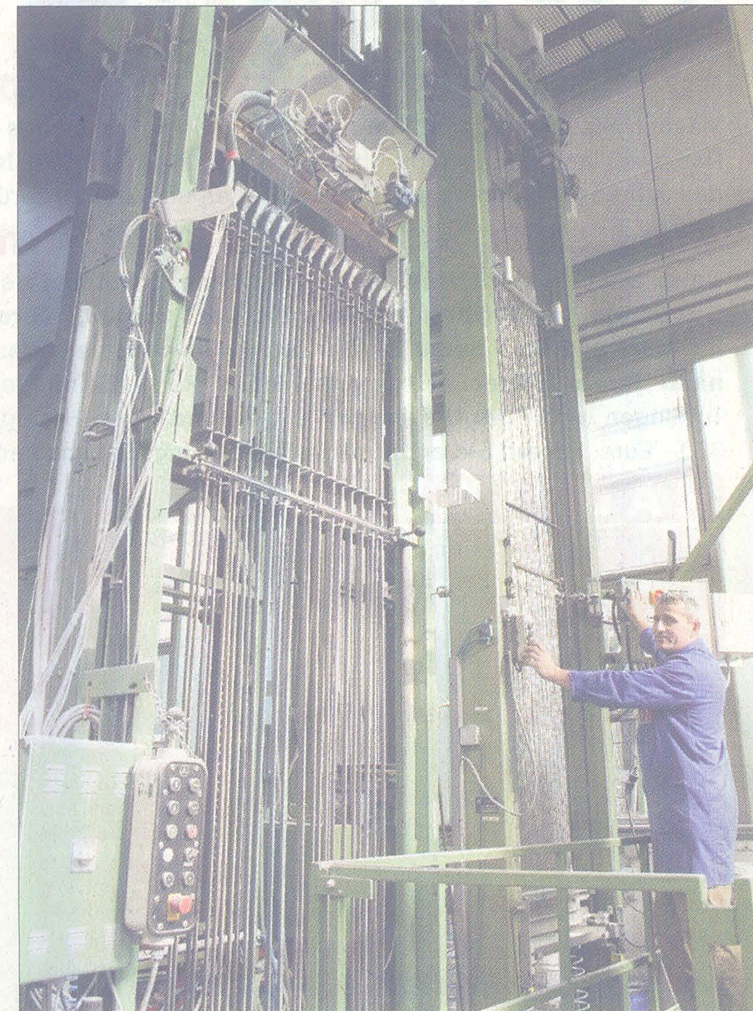
Bis zu 13 Meter hoch sind die Füllstände, an denen die Heizelemente mit Magnesium-Oxid gefüllt werden. Sie machen die hohen, Türk+Hillinger-typischen Fülltürme notwendig.
