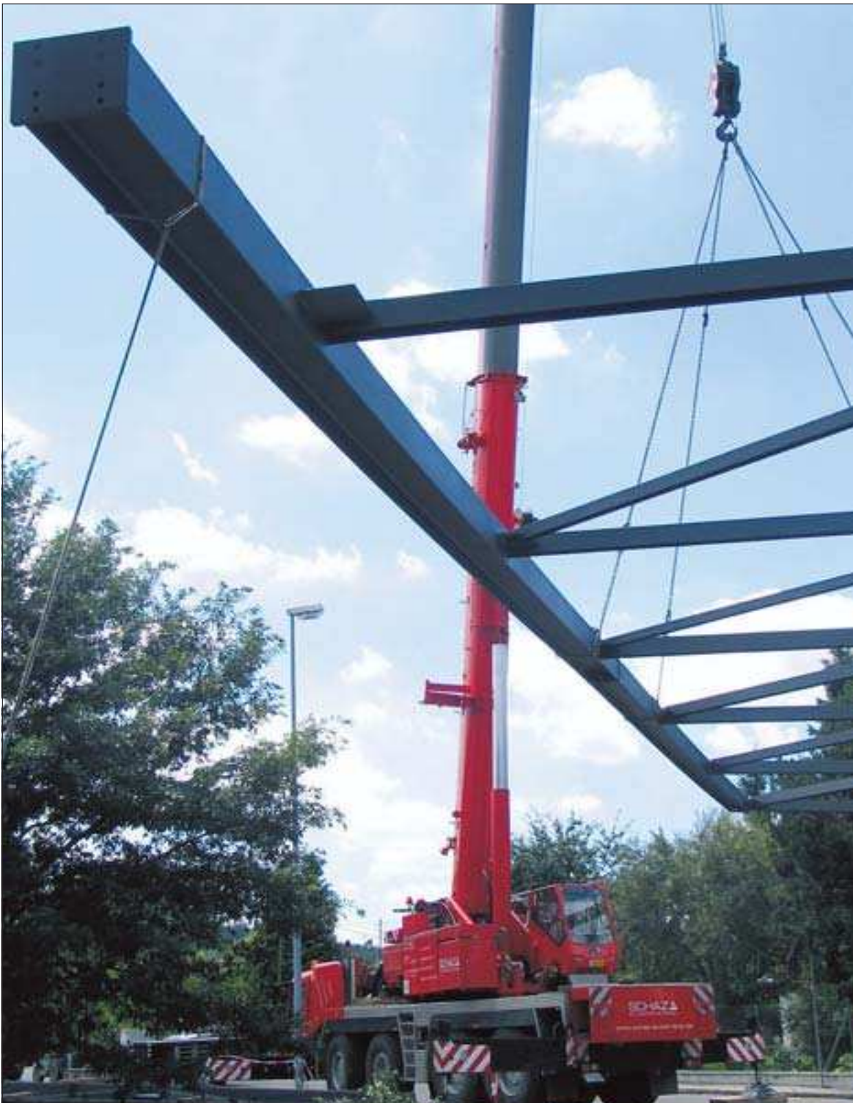
Schwerarbeit leisteten gestern Mensch und Maschine bei Haller Industriebau.
