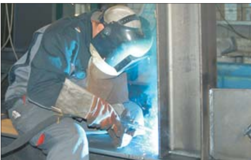
Vor dem Transport wurden die Träger noch geschweißt.
