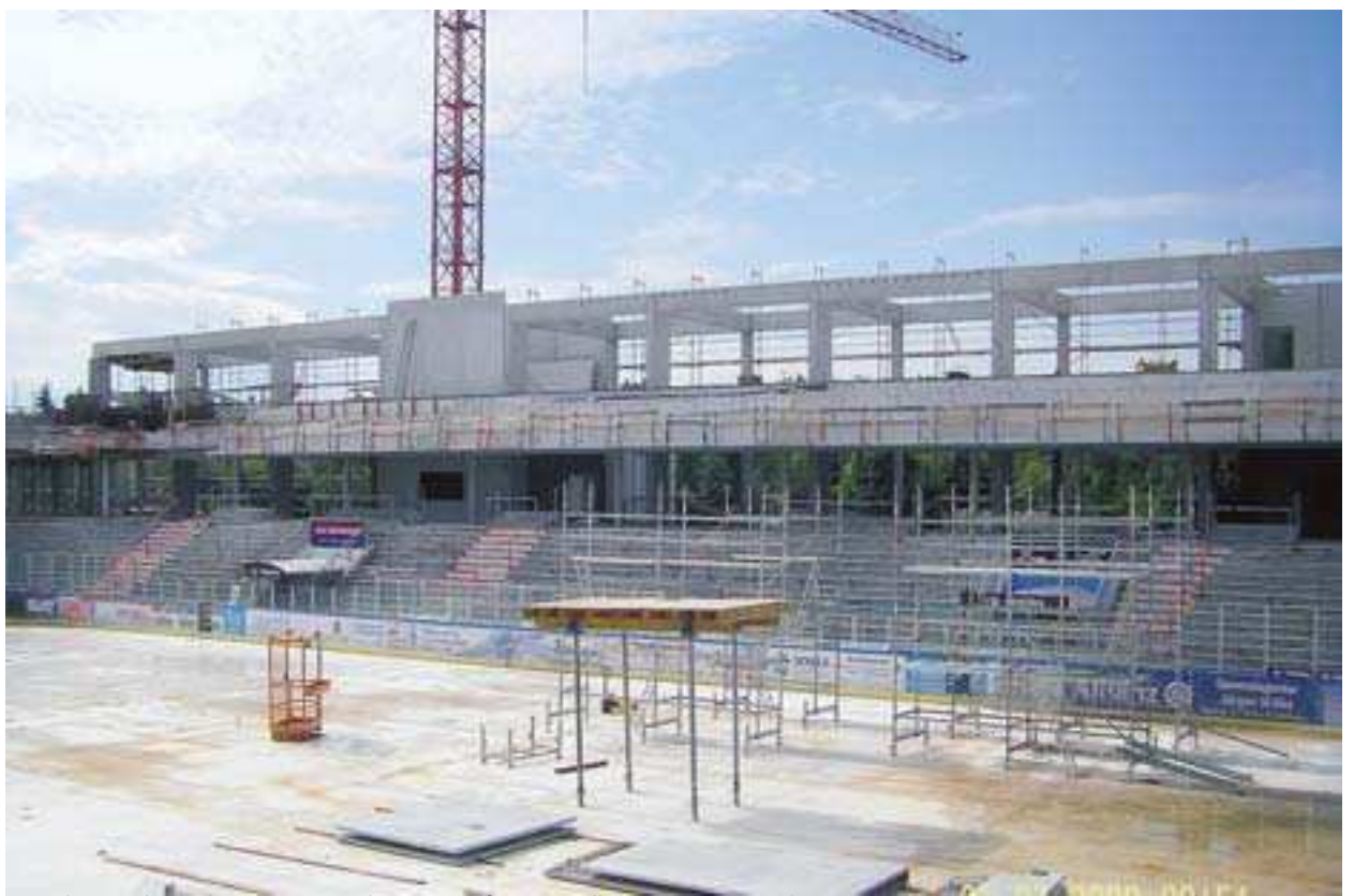
Im Juli war die Helios-Arena noch eine große Baustelle. Hier der Bau des Dachunterbaus mit den neuen Oberrängen.
