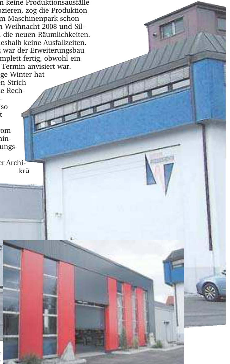
Direkt im Anschluss an das bestehende Würthner-Gebäude entstand in der Neuffenstraße die neue Produktionshalle. Fotos: Sabine Krümmer
