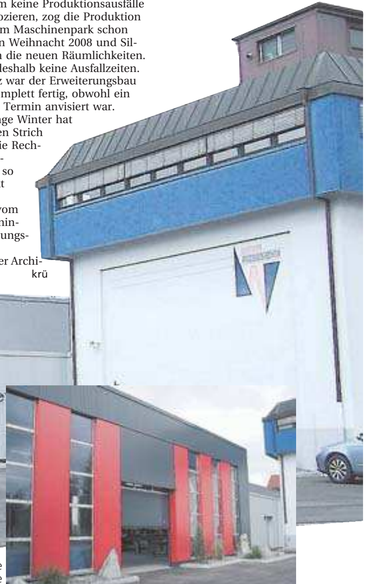
Direkt im Anschluss an das bestehende Würthner-Gebäude entstand in der Neuffenstraße die neue Produktionshalle. Fotos: Sabine Krümmer
