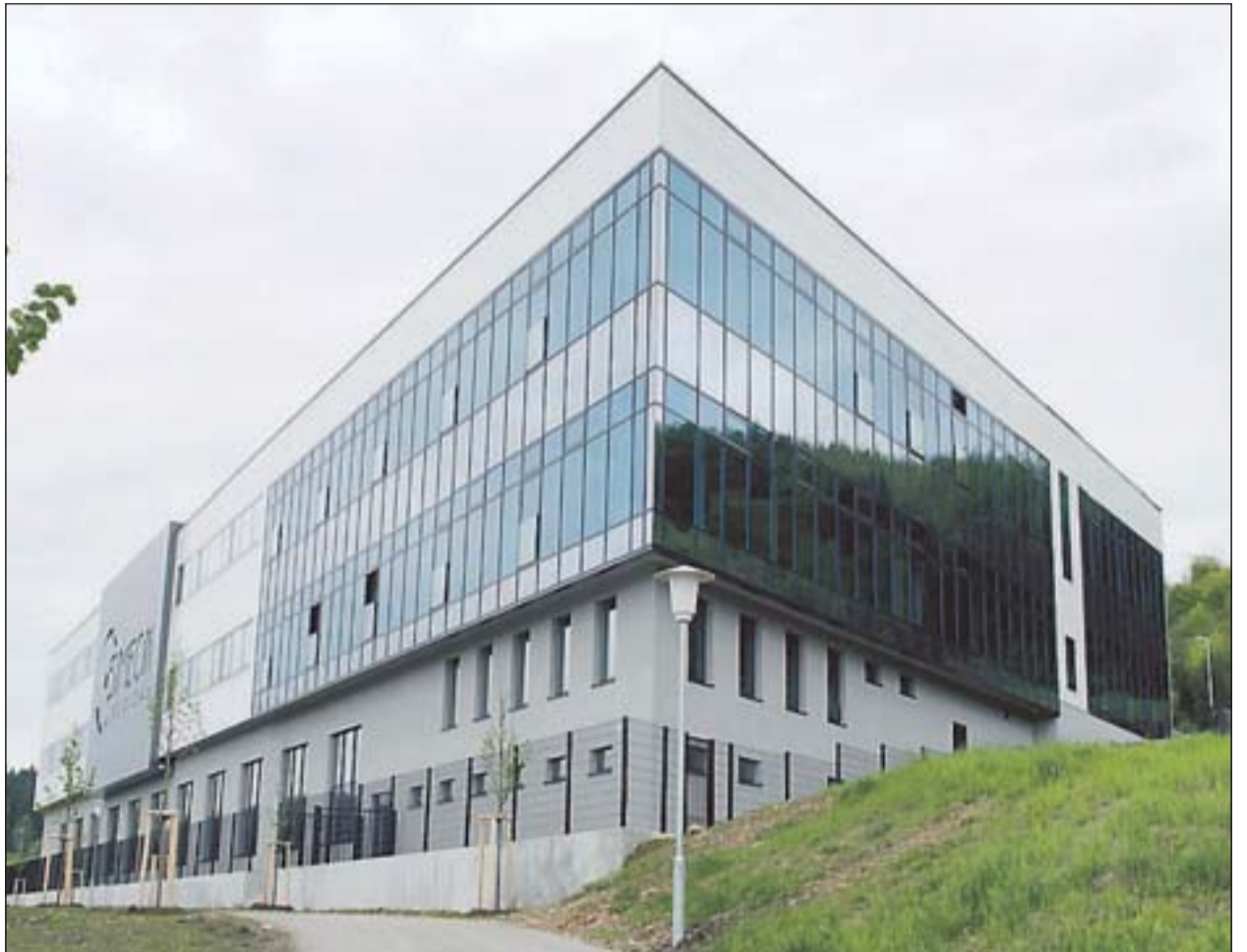
Hoch über Tuttlingen, an der Ausfallstraße Richtung Stockach, steht der imposante Neubau von Simeon Medical. Fotos: Ingrid Kohler
