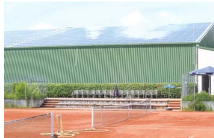
Das Dach der Tennishalle des TC Singen erhielt eine moderne Solaranlage, die Strom für etwa 1100 Haushalte liefern kann. BILD: ROLAND DOST
