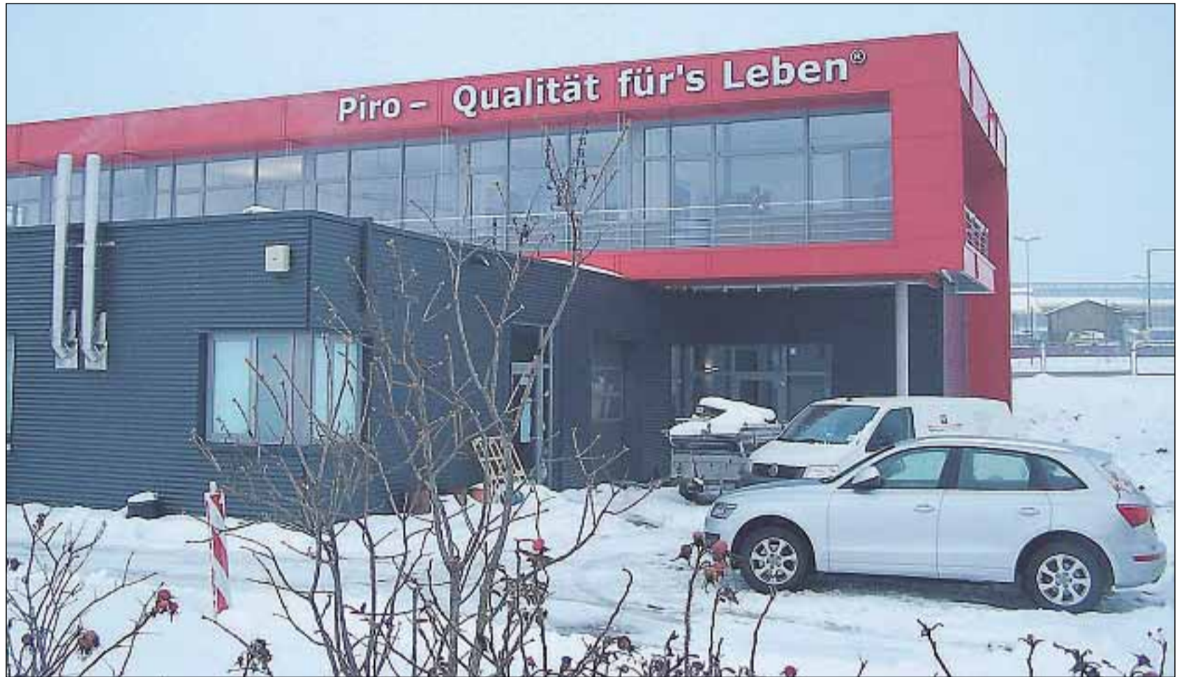
Markant hebt sich der neue Verwaltungstrakt durch seine Farbe vom bisherigen Baukörper ab. Am 10. Januar wurde der Erweiterungsbau der Orthopädie- und Vital-Zentrum Piro GmbH offiziell seiner Bestimmung übergeben. Fotos: Sabine Krümmer
